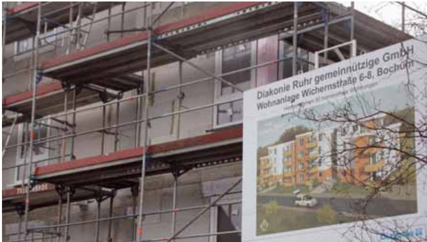
Der Bau an der Wichernstraße macht Fortschritte.
