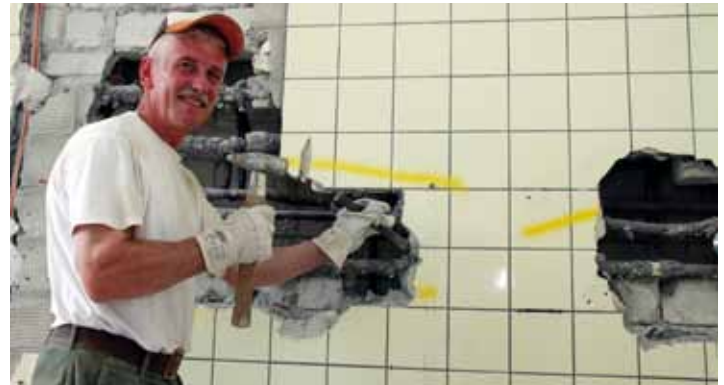
Jan Karkowski von der Abbruchfirma Nelecz legt Rohre frei.
